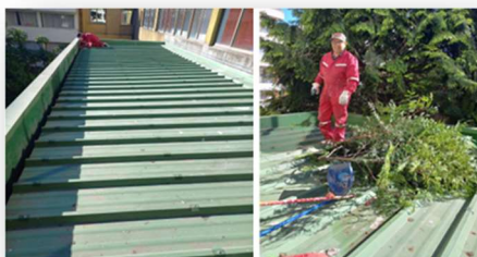
Limpieza Canales Perimetrales
